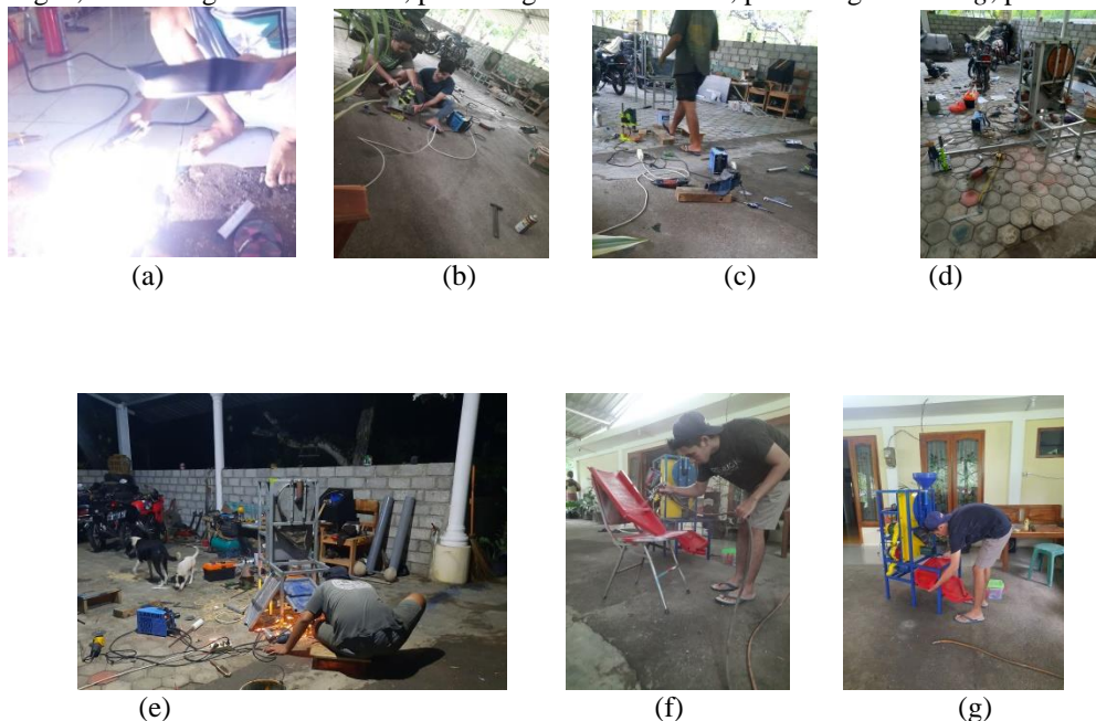
Gambar 5. Proses pembuatan mesin. (a) proses pengelasan, (b) pembuatan pengayak, (c) pembuatan rangka, (d) pemasangan pengupas, (e) pengelasan dudukan pengayak, (f) proses finising pengecatan, (g) perakitan Mesin pengolah gabah dapat dilihat pada gambar 6.
