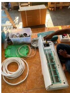
Gambar 1. Persiapan Instalasi Indoor
