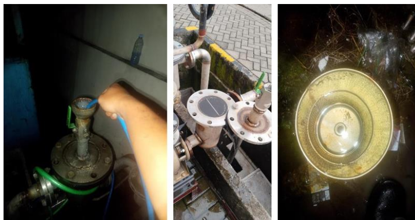
Gambar 6. Proses cleaning strainer dan pemeriksaan komponen
