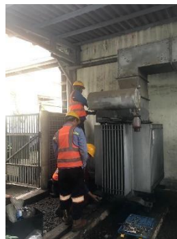
Gambar 13. Foto Penggantian gasket atau seal sambungan transformator
