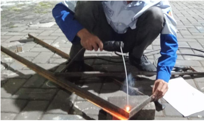
Gambar 5. Proses Pengelasan Menggunakan Mesin Las Listrik
