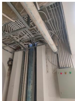
Gambar 3.1.3.1 Pembuatan Sparring Kabel
