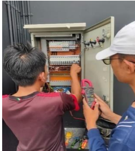
Gambar 3.1.3.5 Pengujian Akhir pada Komponen Panel
