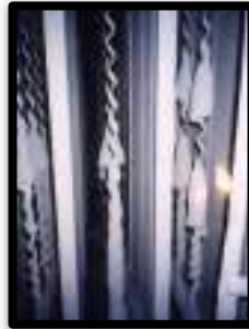
Gambar 4. Collecting Electrode pada ESP
