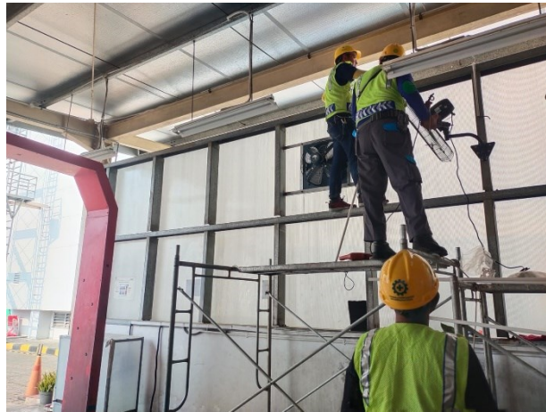
Gambar 4. Proses pemasangan instalasi kelitrikan
