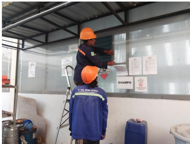
Gambar 5. Proses Pemasangan exhaust fan
