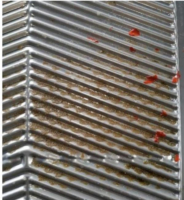
**Gambar 3.** Kotoran di dalam PHE
