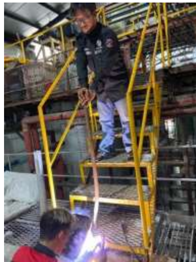
Gambar 3. Proses perbaikan tangga area mesin produksi
