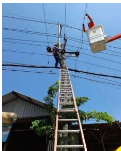
Gambar 2. Penarikan Kabel SUTM di Jaringan SUTM Feeder Mata Air
