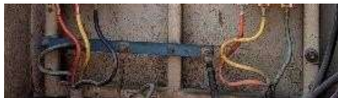
Gambar 3. Busbar Pembagian
