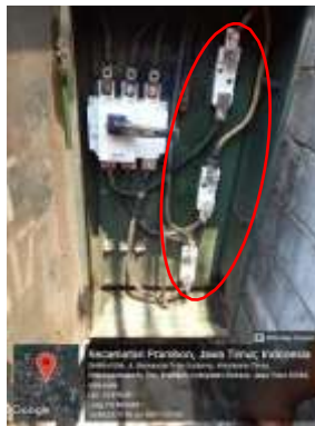
Gambar 5. Penjepit NH Fuse/Kontak Veer
