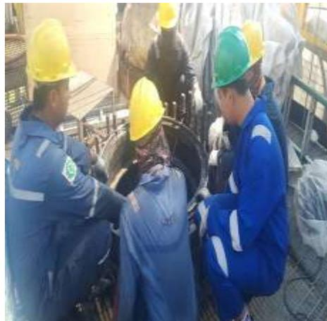
**Gambar 1.6** Pengecekan kotoran yang ada di dalam tangki
