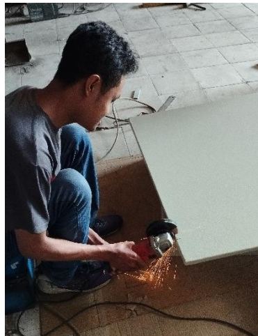
Gambar 2. Pembuatan Box Panel Listrik
