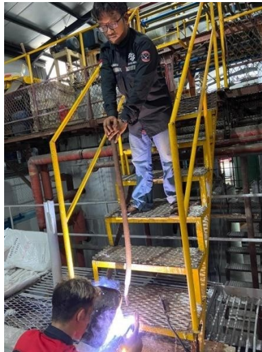
Gambar 3. Proses perbaikan tangga area mesin produksi
