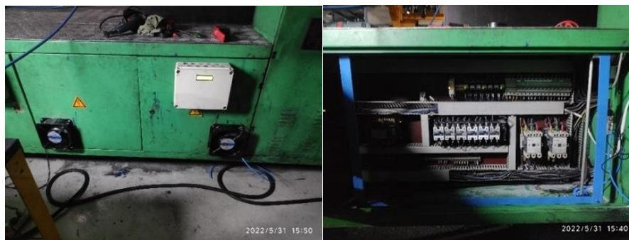
Gambar 5. Pemasangan Keseluruhan Alat
